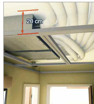
(oben) Schallgedämmte Verteilerkästen für leisen Betrieb. (unten) Verrohrung und Verteilerkästen verschwinden komplett unter der Deckenabhängung.
