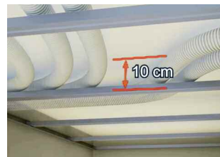
Die minimale Deckenabhängung von nur 10 cm erlaubt eine maximale Raumausnutzung.
