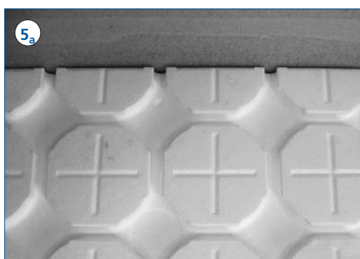
5 a Die Systemplatten müssen an den Kreuzfugen geschnitten werden, so dass eine glatte, nahezu ebene Kante entsteht.
