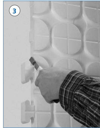
3 Mit der Verlegung muss in einer Raumecke begonnen werden. An den Wandseiten müssen die Positivecken der Platte herausgebrochen werden.
