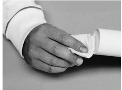
Tragen Sie den Kleber auf das Rohr auf, schieben Sie das Rohr in die Muffe oder den Bogen und warten Sie dann ca. 1 Minute. Jetzt haben Sie eine unlösbare Verbindung zwischen Rohr und Muffe bzw. Bogen geschaffen.
