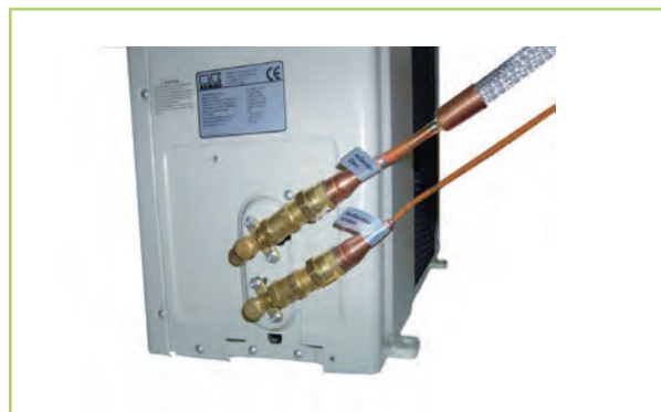
Abb. 36: Installation am Außenteil
