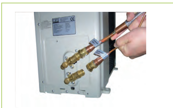
Abb. 35: Position der Schnellkupplungen
