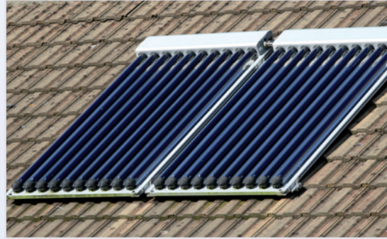
... zur optimalen Nutzung der Solarwärme
